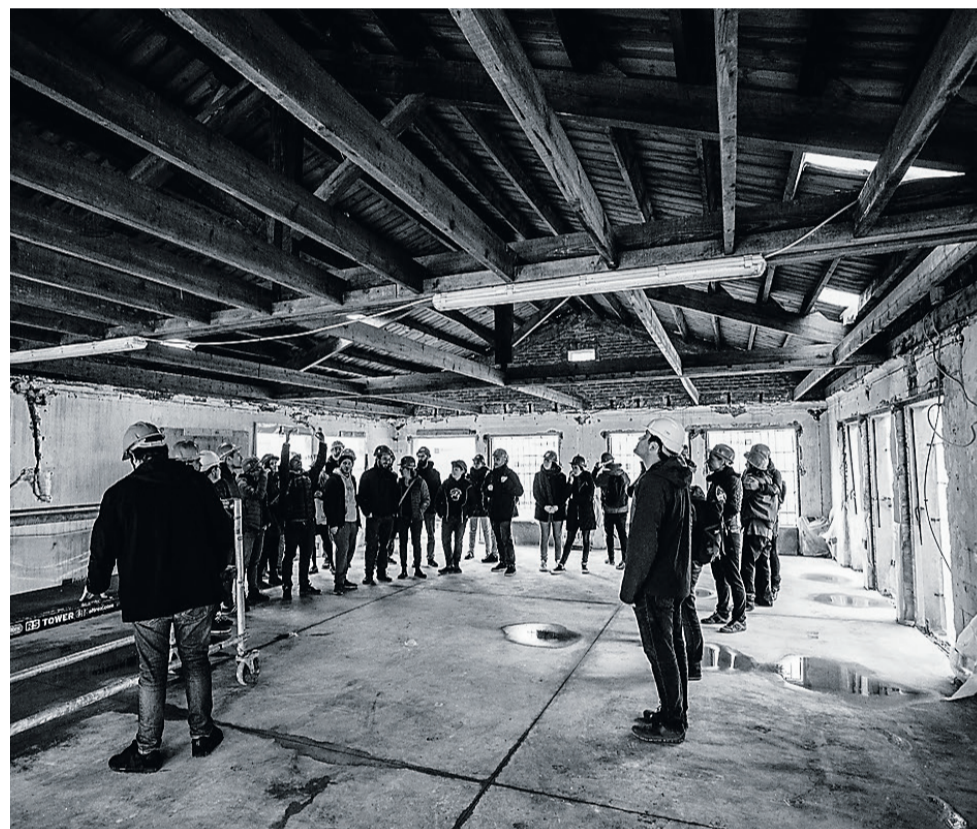
FOTO | Sòcies de La Comunal inspeccionant una de les naus en obres.
