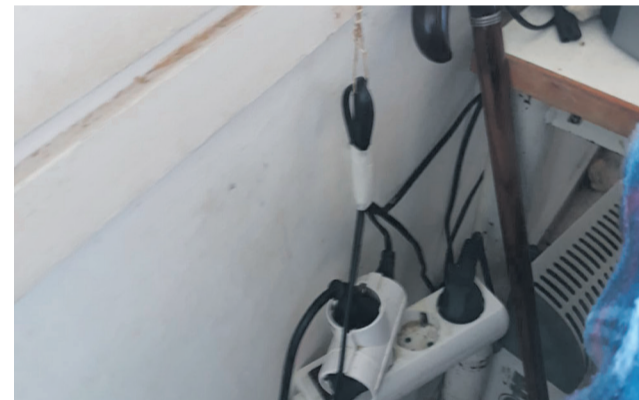
FOTO | Instal·lació elèctrica d'un dels pisos tutelats.
