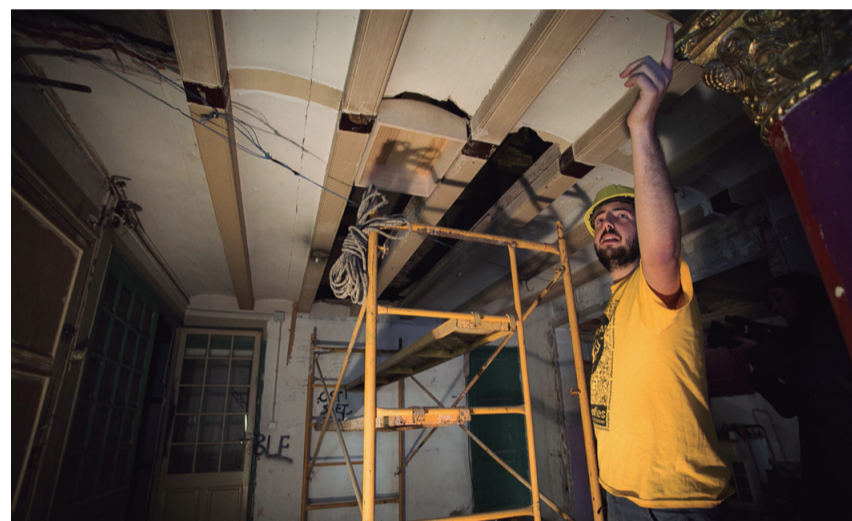
Obres de reconstrucció a Can Vies
