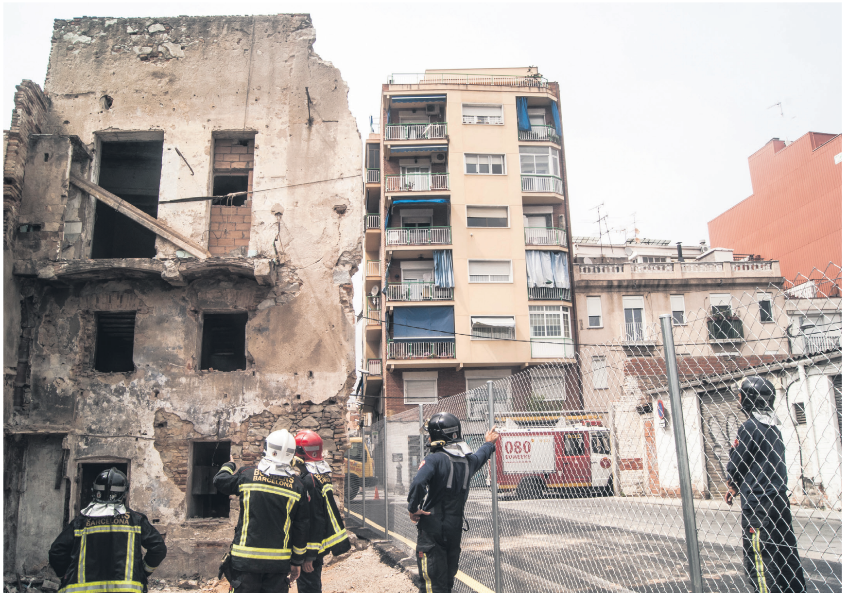
Enderrocament del n° 67 del carrer Constitució
