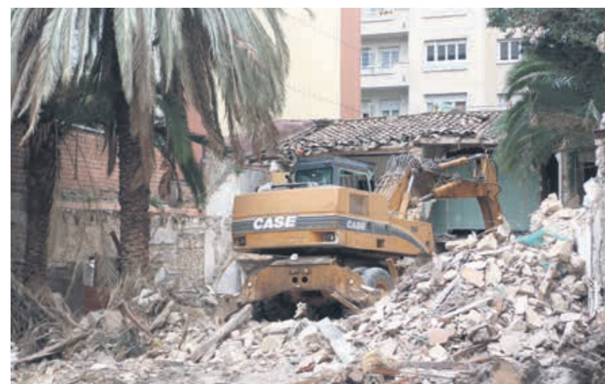
Enderrocament del 214 del carrer de Sants
