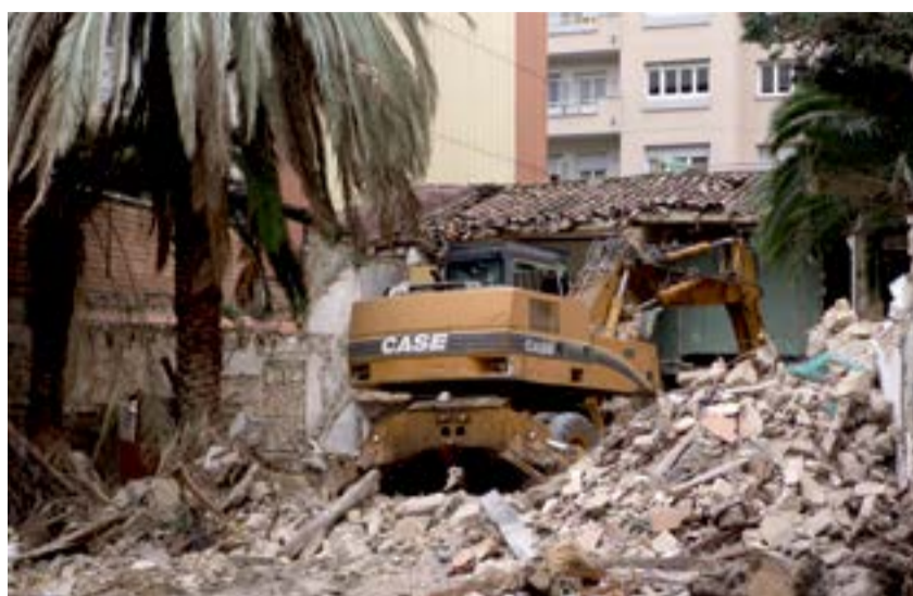
Enderrocament del 214 del carrer de Sants
