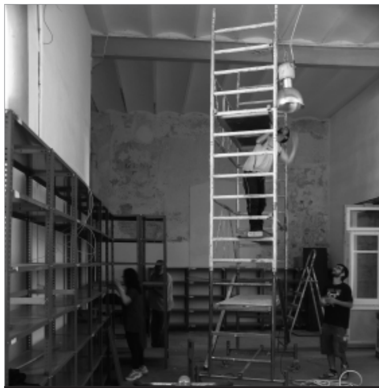
El veïnat de totes les generacions ha participat de la rehabilitació de la nau. JORDI SOLÉ
