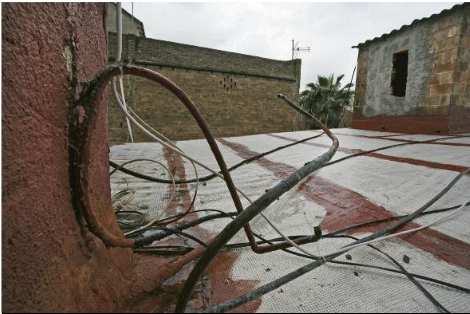
Estat de les canonades d'aigua del terrat de casa de na Gloria. ALBERT GARCIA
