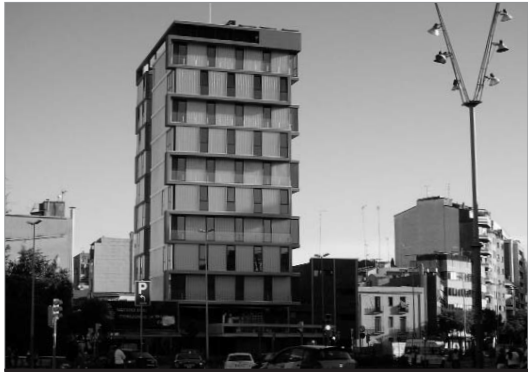
La Torre Malaia té 11 plantes però els edificis del seu voltant no en tenen més de 5. ESTER
