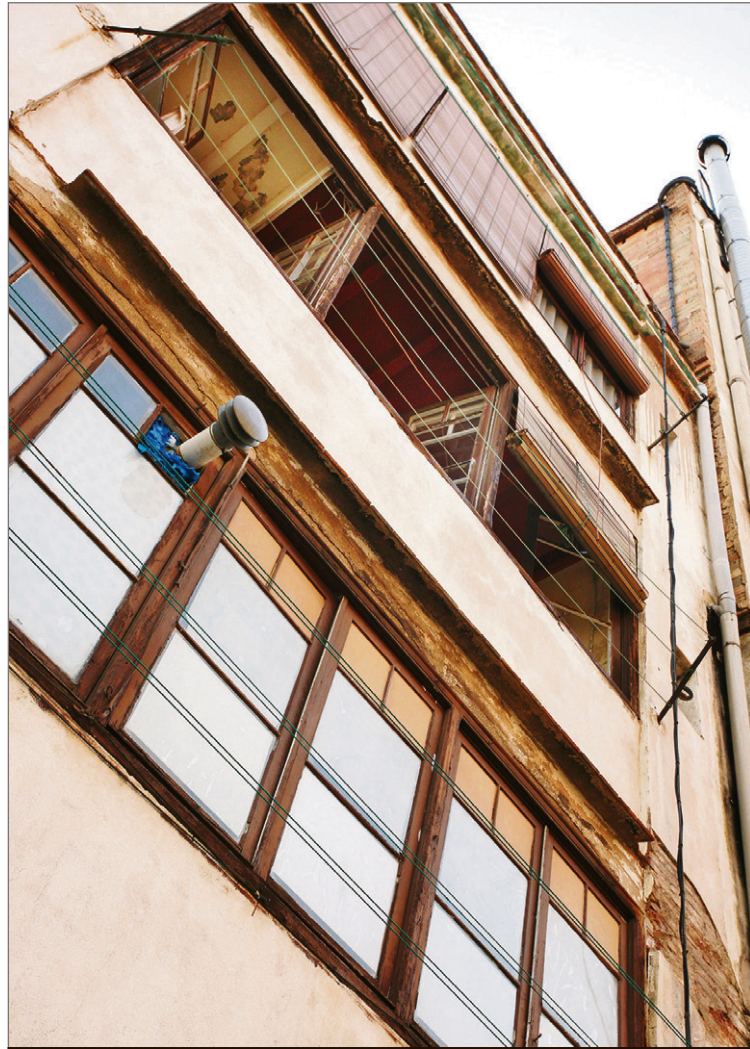
Façana interior de l'edifici. Les finestres obertes dels pisos deshabitats (a la imatge el 2n 2a, al mig) fan que la pluja entri i es filtri a la resta d'immobles. ALBERT GARCIA
