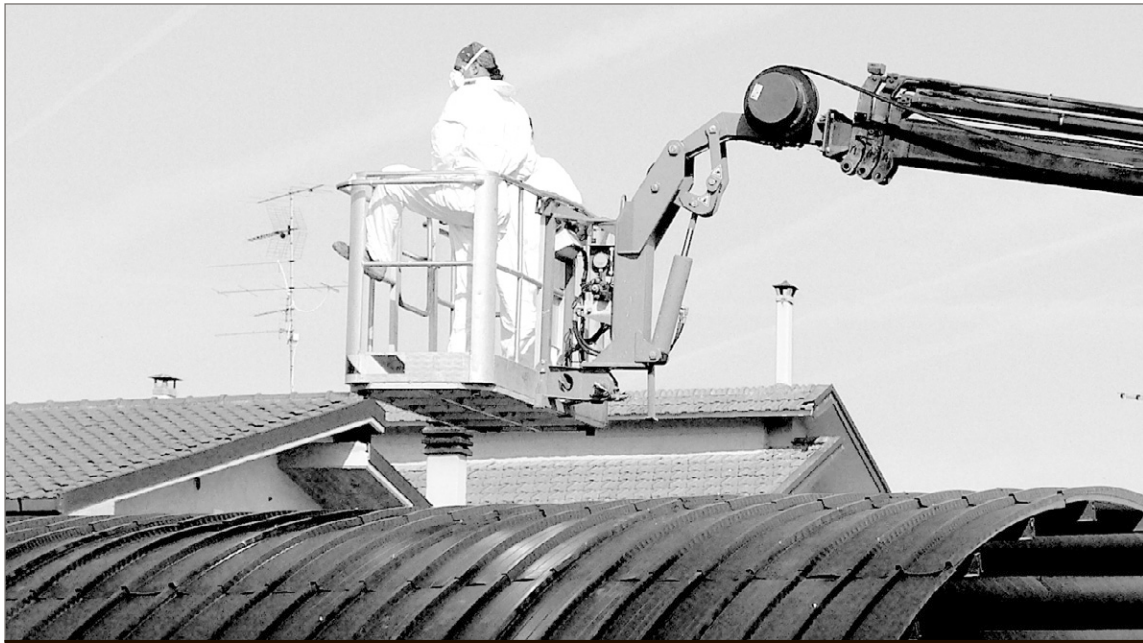
Operaris treballen sobre un sostre fet d'amiant. Han de dur roba protectora a causa de la perillositat de la matèria. FLICKR
