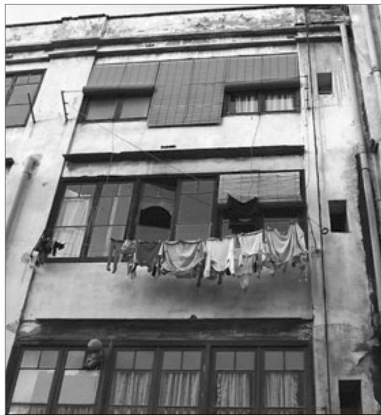
El desguaç de la façana interior és una de les reparacions que s'han de fer. ALBERT GARCIA
