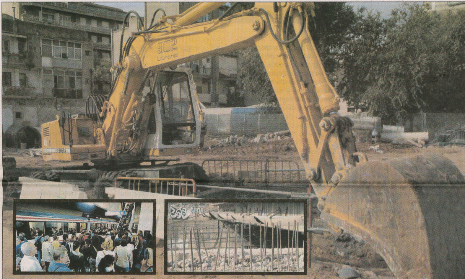
Els problemes col·laterals que provoquen les obres del tren d'alta velocitat (TAV) afecten usuaris de Renfe, treballadors i veïnat.
