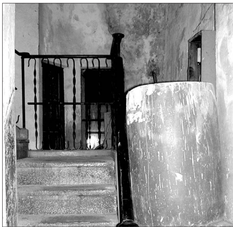
Imatge de l'estat de degradació de l'edifici del carrer Càceres, 9.
