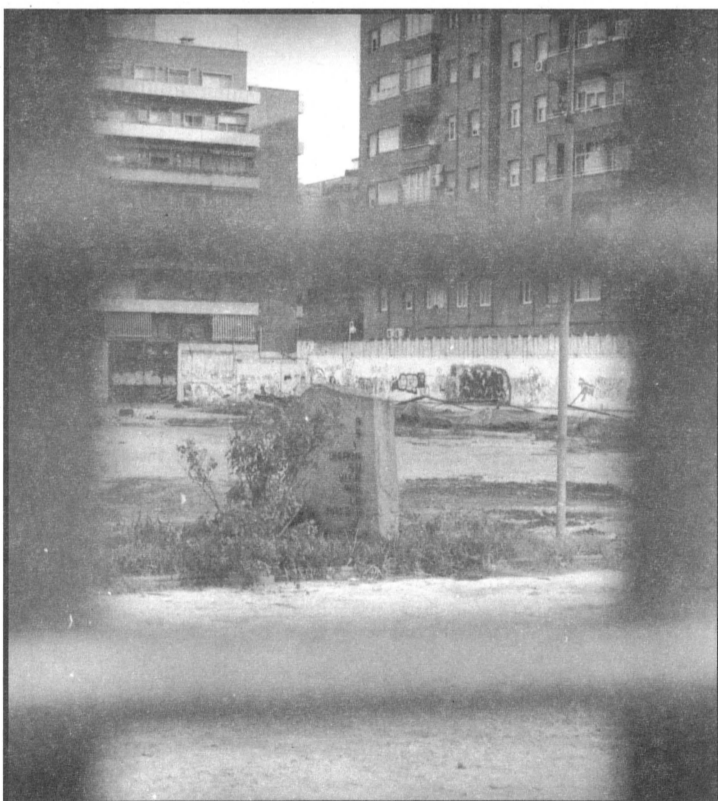
Aspecte de la Caserna després d'iniciar-se l'enderroc.
