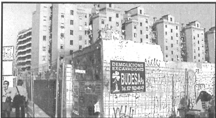
Restes de la façana de la caserna militar als inicis de març
